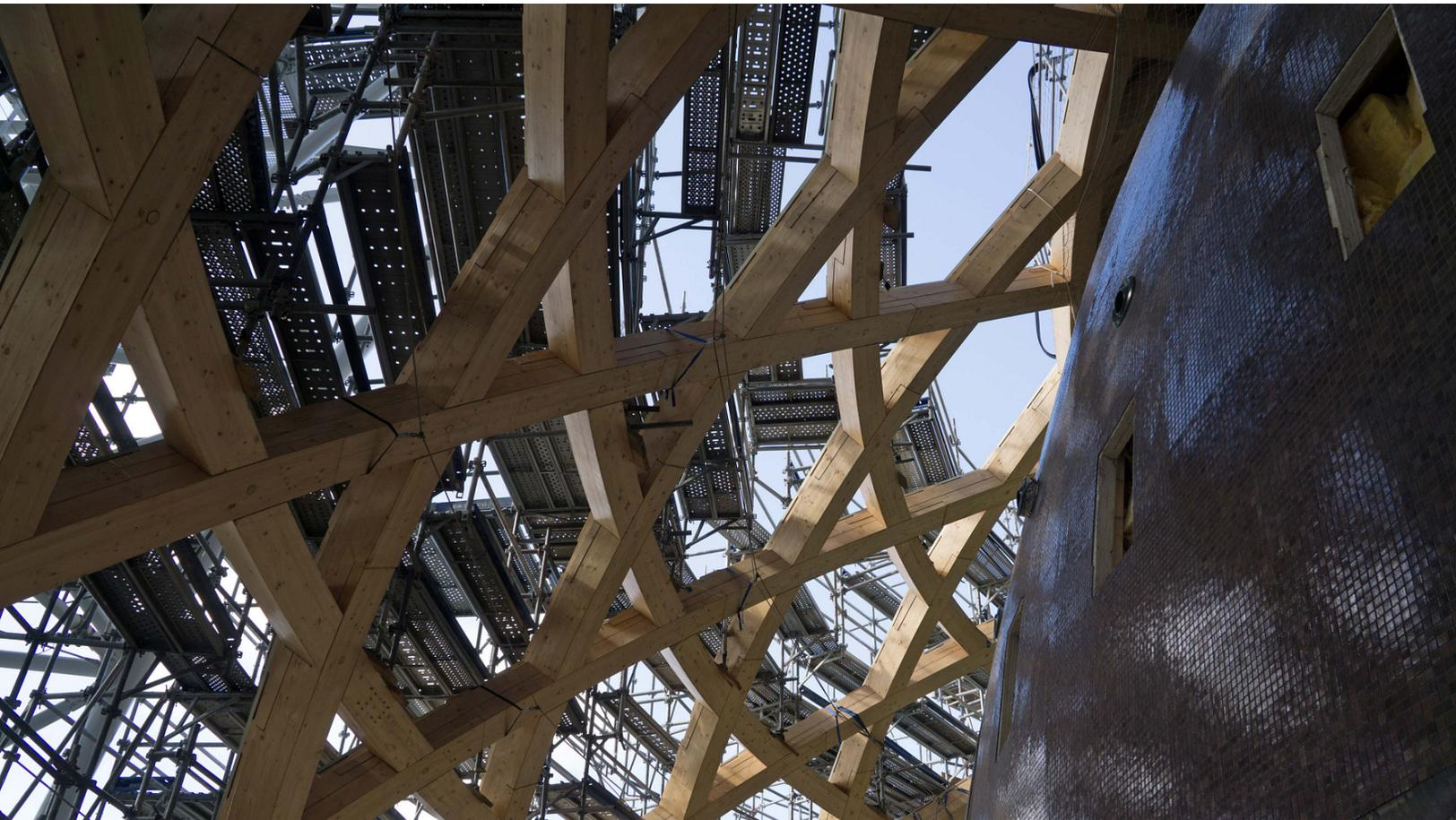
Umsetzbar auch dank der digitalen Möglichkeiten: Die doppelt gekrümmte Primärstruktur von La Seine Musicale in Paris. Bild: Design to Production
